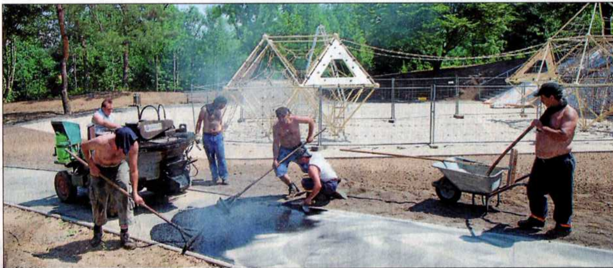
Heißer Job: Mitarbeiter der Baufirma legen auf dem neuen Spielplatz Wege an. FOTOS: BARBARA FROMMANN
